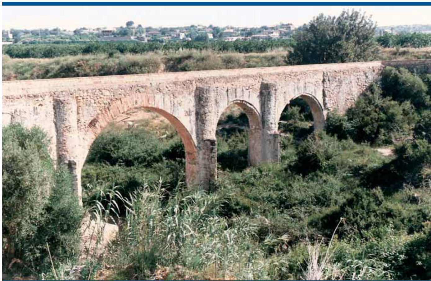
Arquets de Baix (Torrent), al barranc de La Cotienda
